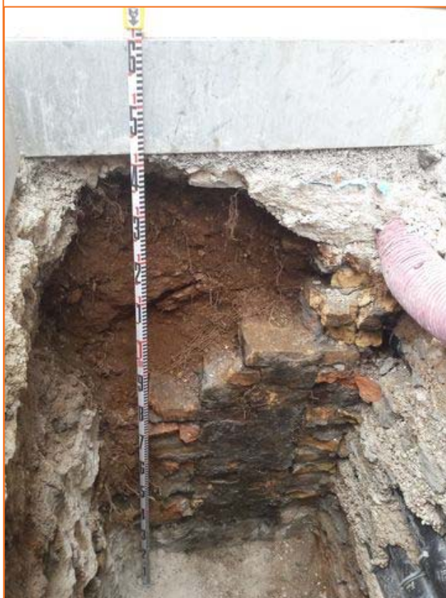
Foto 134. Imatge de la Cala 69 amb l'estructura de maó
