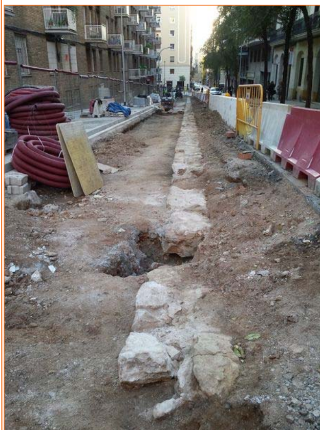
Foto 23. Vista general SO de la fonamentació UE 122
