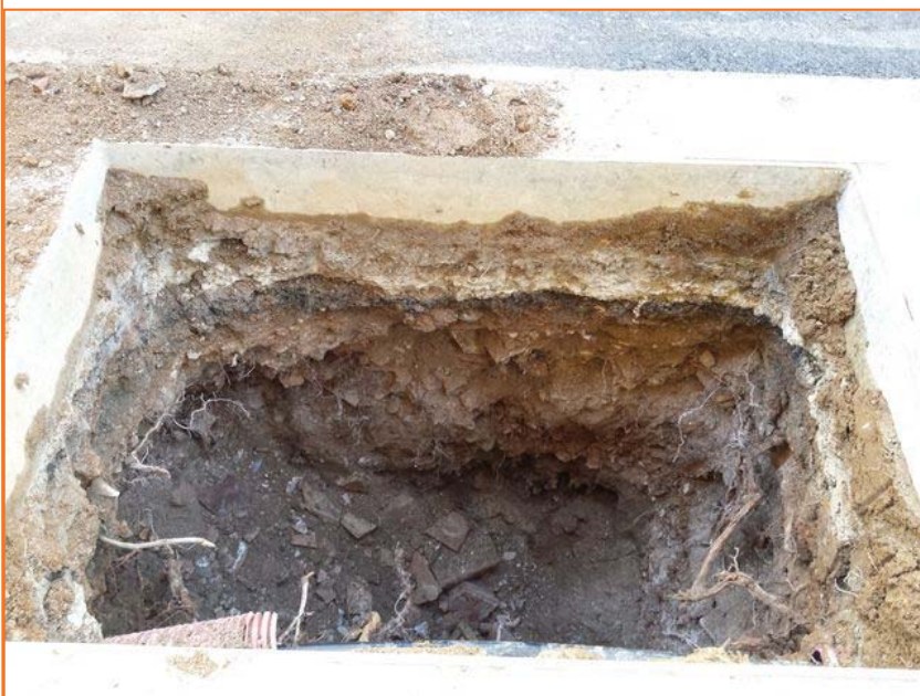
Foto 65. Vista de la Cala 22
