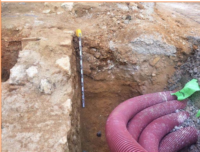
Foto 122. Estratigrafia associada a la cara SE de les estructures (perfil NE de la Cala 41)
