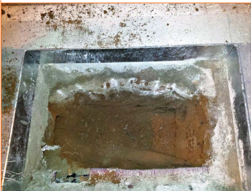
Foto 64. Vista de la Cala 20
