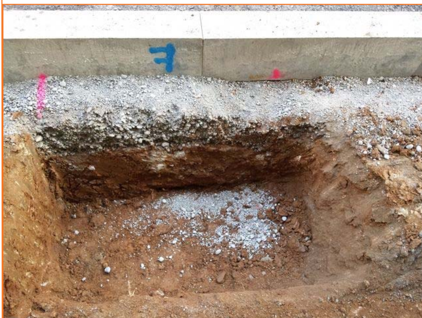
Foto 69. Vista de la Cala 19
