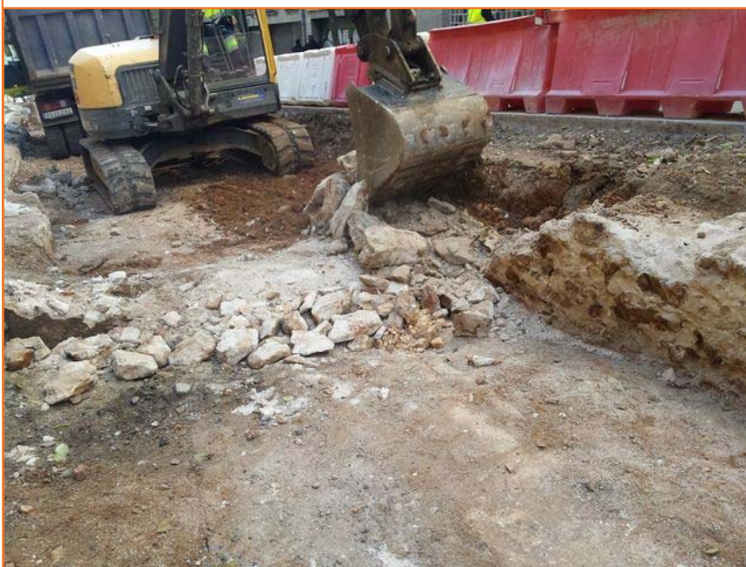
Foto 160. Desmuntatge de la UE 122 a la Rasa 4
