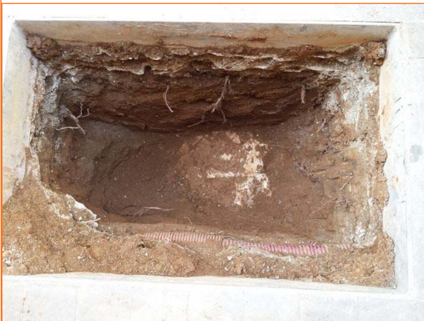
Foto 67. Vista de la Cala 25
