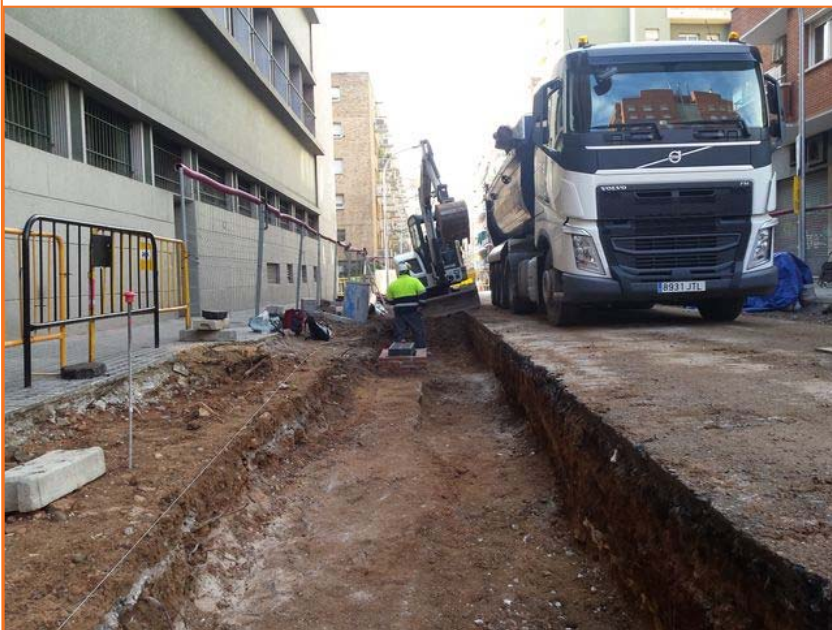
Foto 85. Vista SO de la Rasa 13 del tram situat a l'alçada de la finca núm. 52-56
