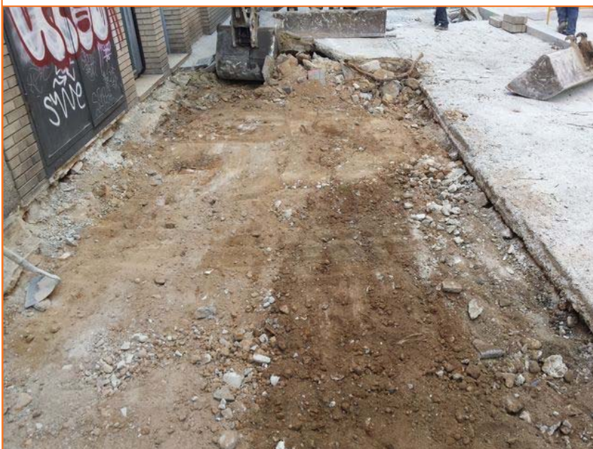
Foto 154. Treballs de rebaix davant la finca núm. 63-65
