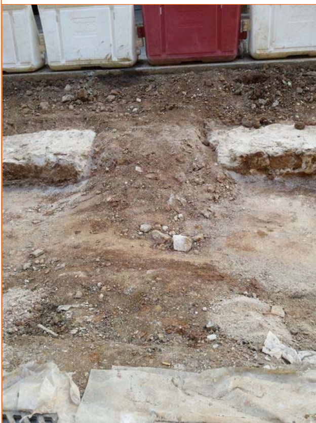
Foto 37. Imatge del servei elèctric UE 131 i el seu reompliment UE 132
