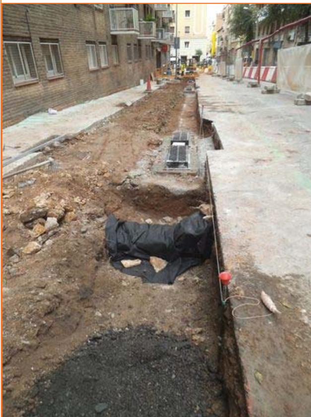
Foto 159. Vista de la col·locació de geotèxtil al mur UE 104 dins de la rasa 3
