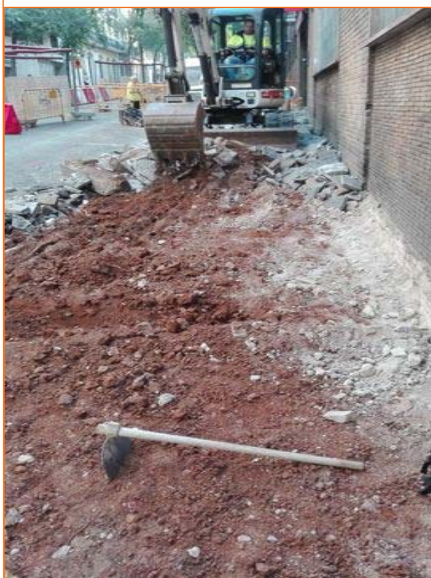
Foto 70. Vista de la retirada dels panots de la vorera
