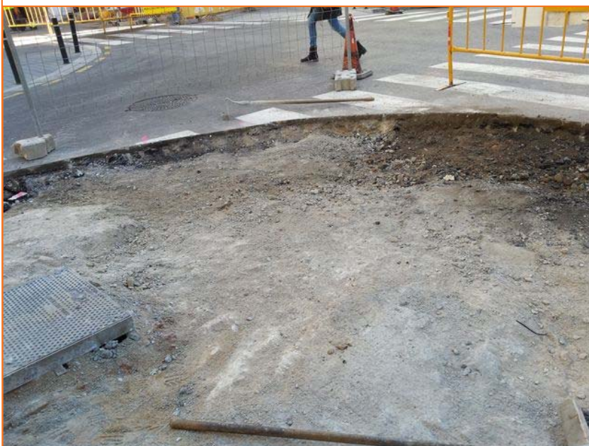
Foto 80. Cantonada nord del Sector 1 un cop realitzat el rebaix
