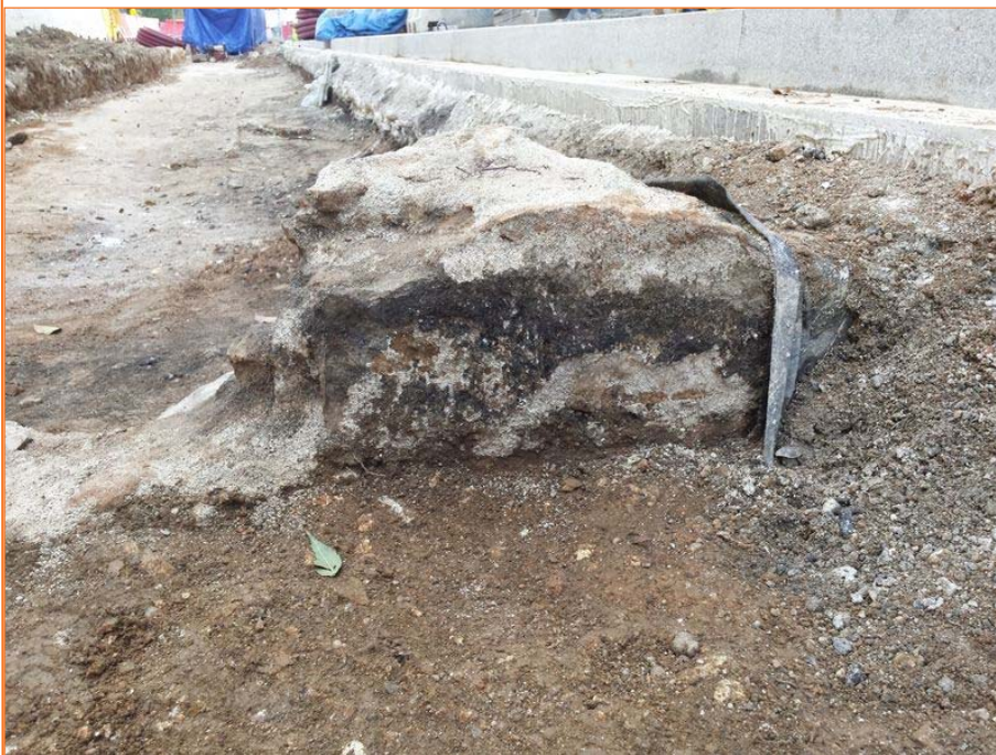
Foto 21. Imatge de detall de l'enllobit de la cara SO de la UE 104
