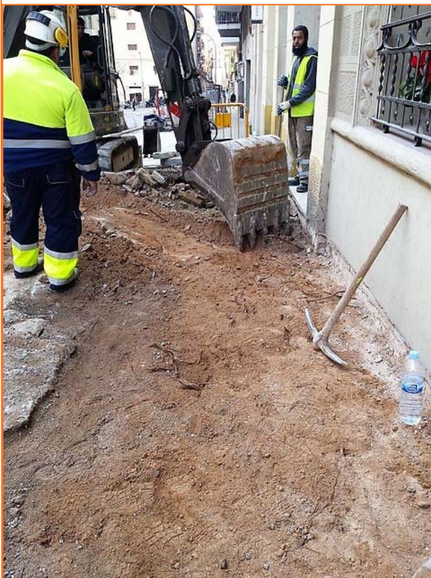
Foto 79. Imatge dels treballs de rebaix de la vorera del costat muntanya tocant al edificis del carrer
