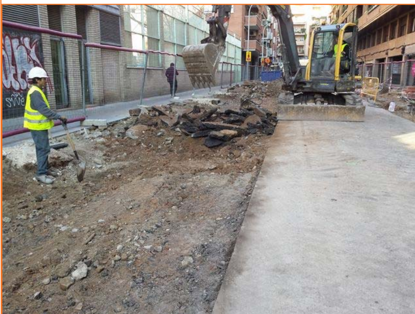
Foto 147. Treballs de rebaix davant la finca núm. 63-65
