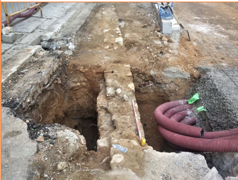
Foto 115. Vista general cap al NE de les estructures i la cala 41
