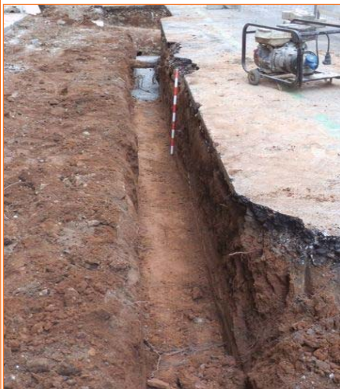
Foto 7. Imatge de la Rasa 2
