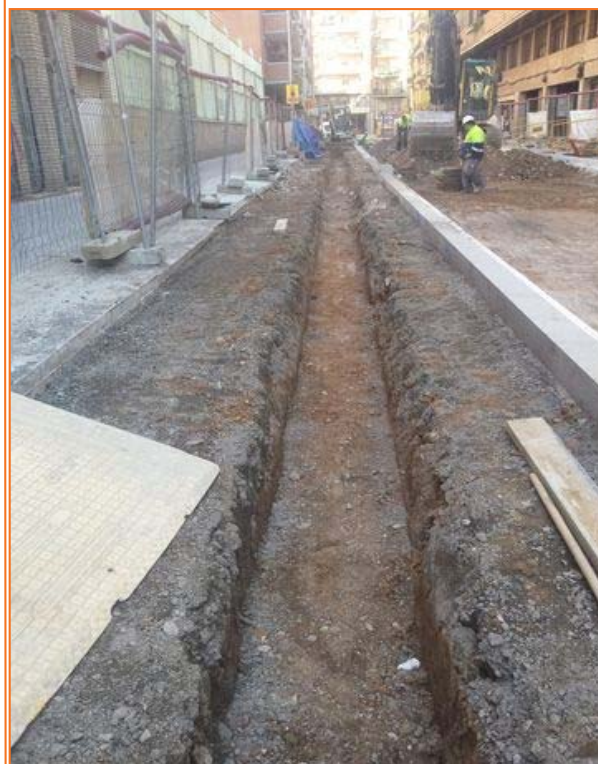
Foto 92. Imatge NE de la Rasa 18 a l'alçada de la finca núm. 67-87
