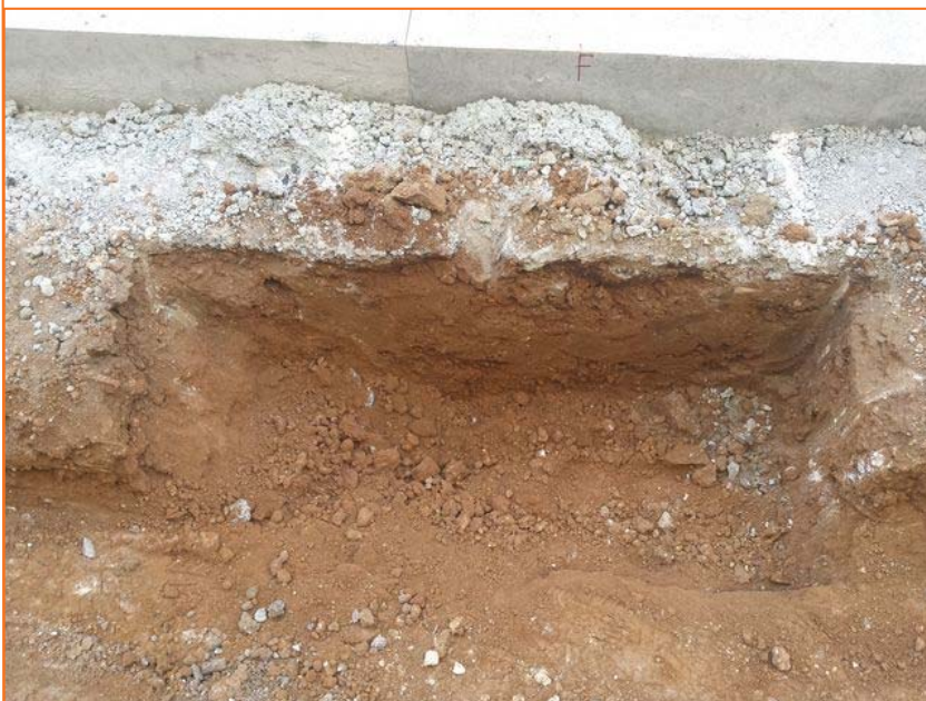
Foto 68. Vista de la Cala 10
