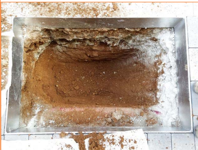
Foto 63. Vista de la Cala 12
