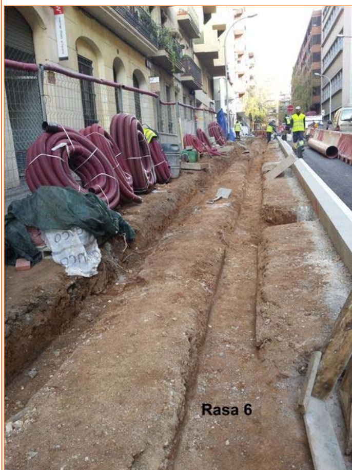
Foto 48: Imatge de la rasa 6
