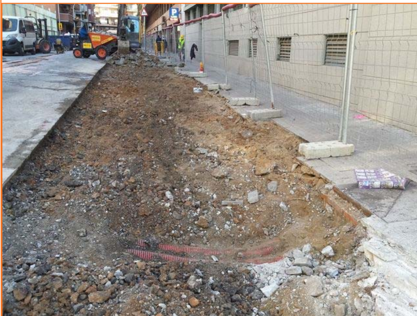
Foto 145. Treballs de demolició de part de la vorera mar i vista un cop recollida la runa a l'alçada de les finques núm. 52-58 i 60-62
