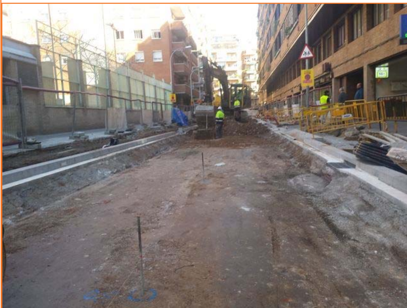
Foto 143. Vista dels treballs de rebaix de la calçada a l'alçada de la finca núm. 60-62
