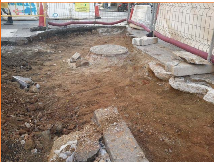
Foto 155. Imatge de la Cantonada est després de realitzar el rebaix
