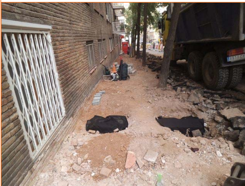
Foto 158. Vista del cobriment del mur UE 104 amb geotèxtil a la vorera de mar (Sector 1)
