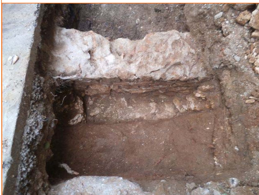
Foto 12. Vista de detall de la rasa de fonamentació UE 108
