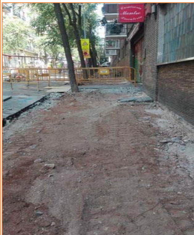
Foto 71. Vista general una vegada estreta la vorera
