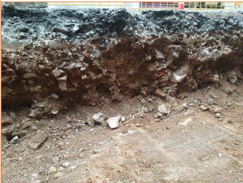
Foto 144. Estratigrafia de la calçada a l'alçada de la finca núm. 72
