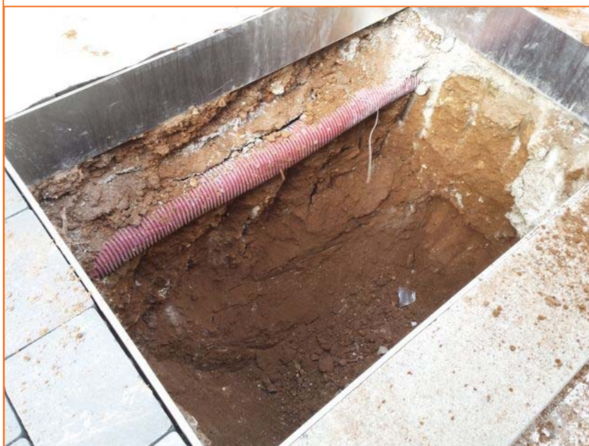
Foto 62. Vista de la Cala 9
