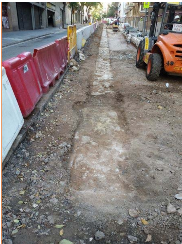
Foto 24. Vista general NE de la fonamentació UE 122
