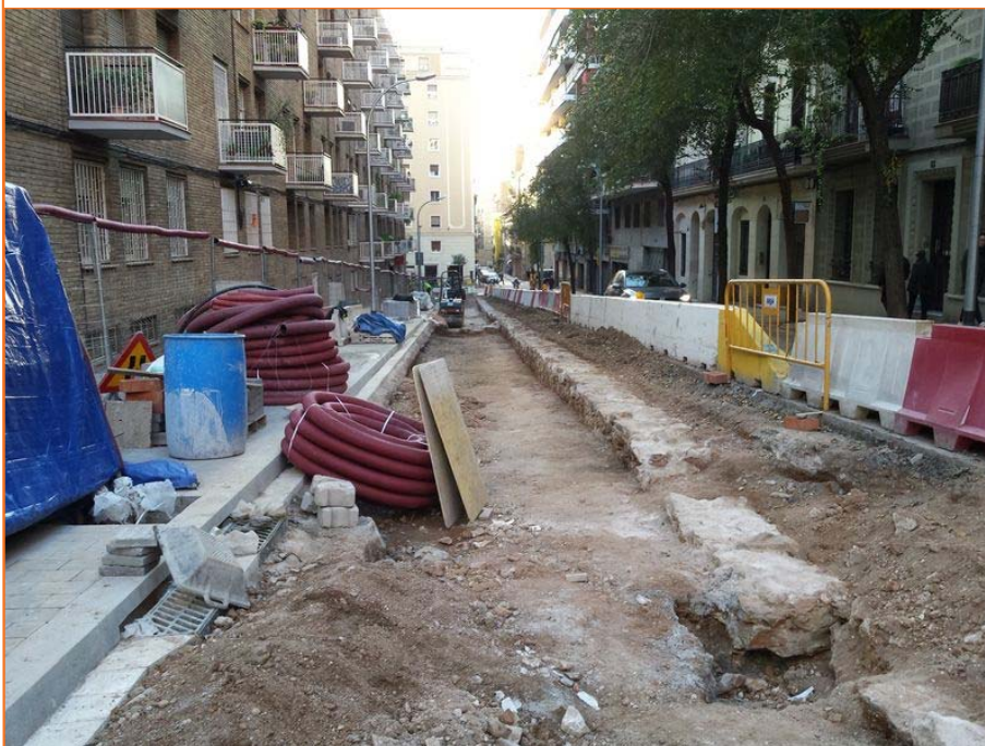
Foto 25. Imatge general SO de la fonamentació UE 122
