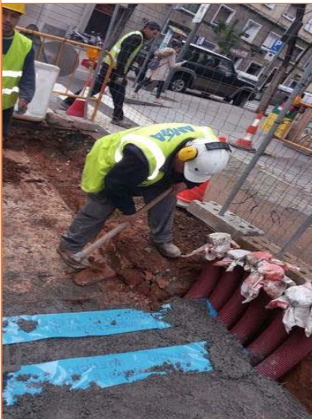
Foto 161. Desmuntatge de la UE 142 a la Rasa 5
