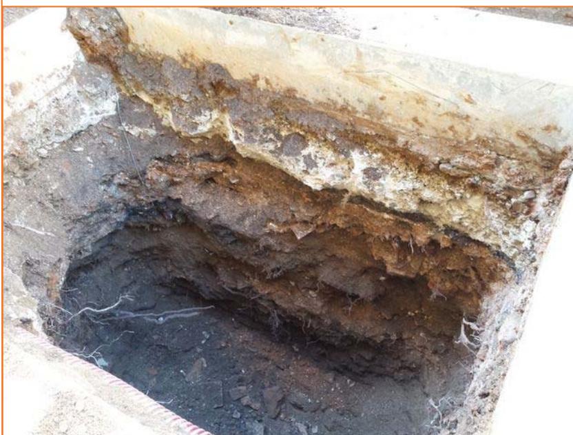
Foto 66. Vista de la Cala 24
