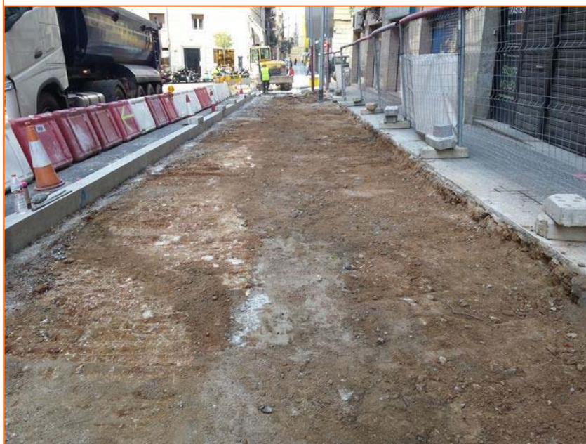
Foto 78. Imatge de la vorera del costat muntanya un cop realitzat el rebaix de la part més pròxima a la calçada.
