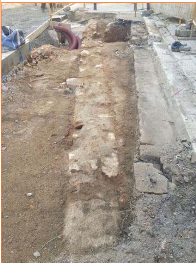
Foto 148. Vista general SO de la UE 146
